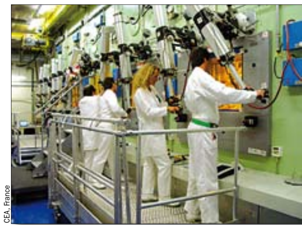
Vue de la cellule chaude CBP à Atalante.
