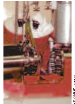
Inspection d'une pompe d'évacuation de chaleur résiduelle à la centrale nucléaire de Beznau en Suisse.
