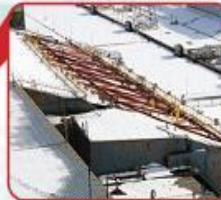
Южная зона. Соединение южных щитов со щитами-кюшками Southern zone. Connection of Southern panels with "Hockey sticks"
