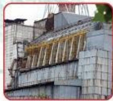
Северная зона. Объединение контрфорсной стены со щитами-кюшками Northern Zone. Connection of Buttress Wall with "Hockey sticks" panels
