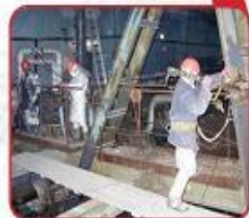
Южная зона. Стабилизация каркаса дезераторной этажерки Southern zone. Stabilization of Deue rator Stack frame
