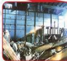
Южная зона. Усиление западной опоры балки «Мамонт» Southern zone. Reinforcement of Western support of Mammoth beam
