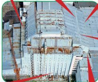
Южная зона. Стабилизация каркаса дезераторной этажерки Southern zone. Stabilization of Deue rator Stack frame
