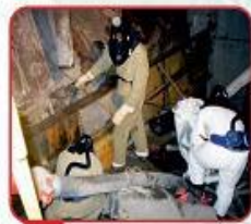
Южная зона. Усиление восточной опоры балки «Мамонт» Southern Zone. Reinforcement of Mammoth beam eastern support
