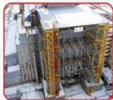
Западная зона. Усиление западного фрагмента Western Zone. Reinforcement of the Western fragment
